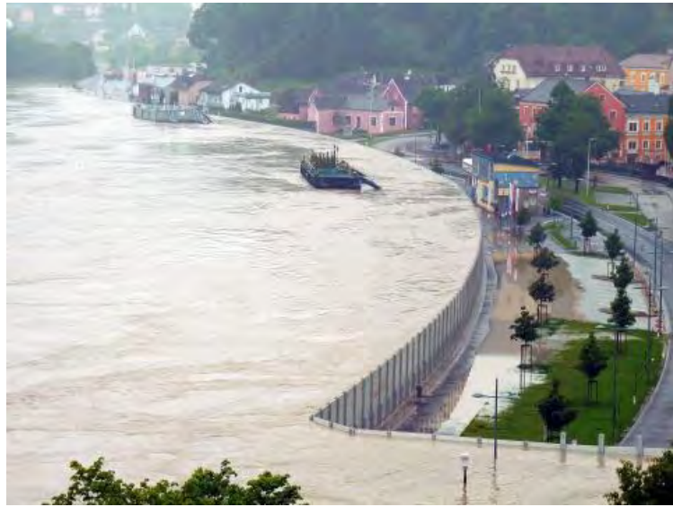
欧州の河川に設置されている組立式の洪水防止壁。高さ5mの壁から市街地を守っています。(写真提供＝日本仮設株式会社)
