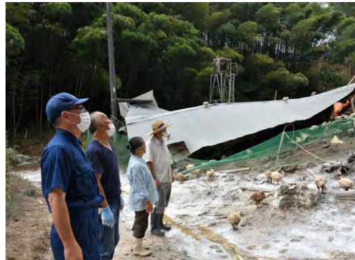
法面崩落で押しつぶされた鶏舎を調査(南関町)
