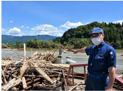
被災した球磨川第四橋梁を視察(相良村)
