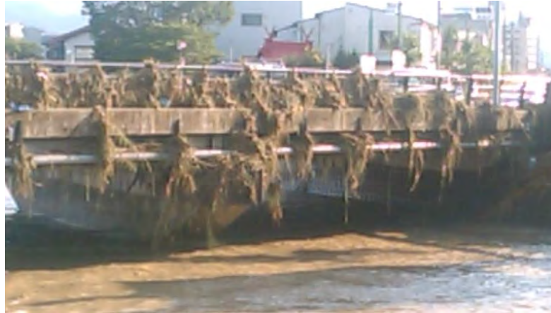
人吉市街地を流れる山田川。上流側からの越水が欄干にぶつかり、市街地に流れていった痕跡が残っています(7月4日山本伸裕撮影)
