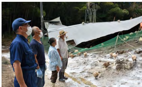
土砂崩落で全壊した鶏舎を調査(26日南関町)
