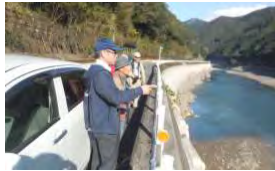
瀬戸石ダムの土砂堆積状況を調査(芦北町)
