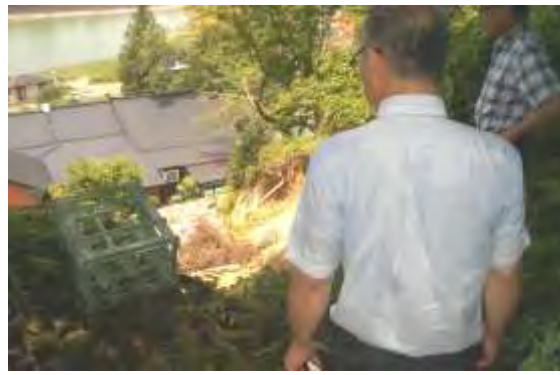
人吉市での土砂崩落現場を調査
