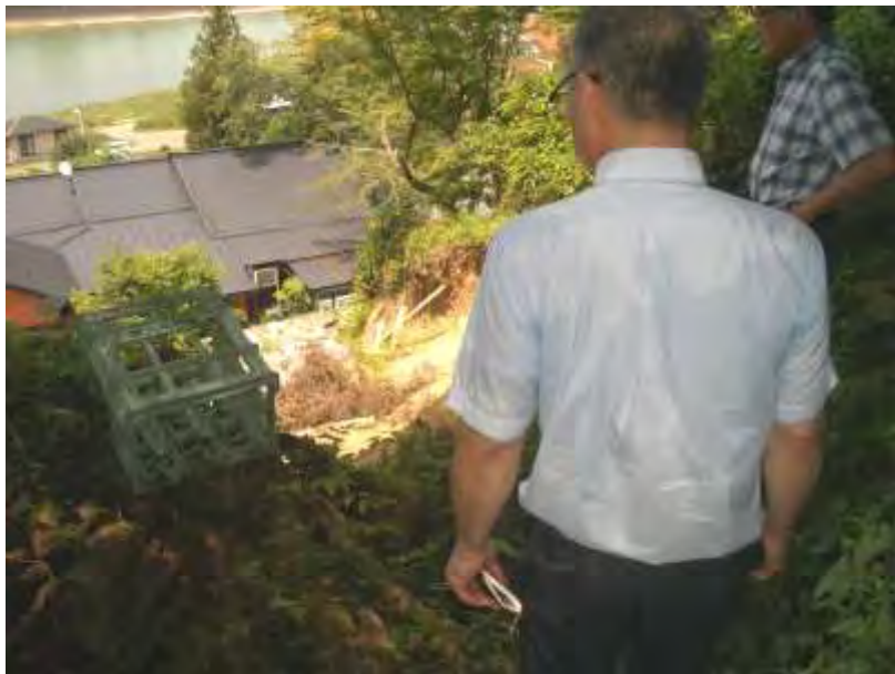
崩落した斜面の上から現場を視察する山本のぶひろ県議。崩落した土砂は家屋に迫り、危険な状況でした。=7月28日、人吉市
