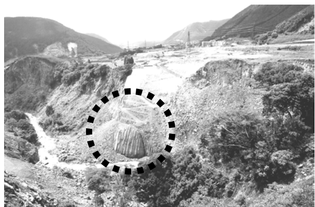
壊された柱状節理。ジオパーク認定には厳格な保存と管理の規定があります。地元は何の相談もなく破壊した行為に批判が高まっています(今年8月撮影)。
