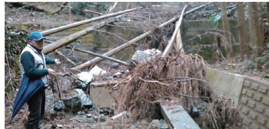
地震後の大雨で、土砂と倒木でふさがった甲佐町の砂防ダム。雨のたびに下流住民は避難されています。
