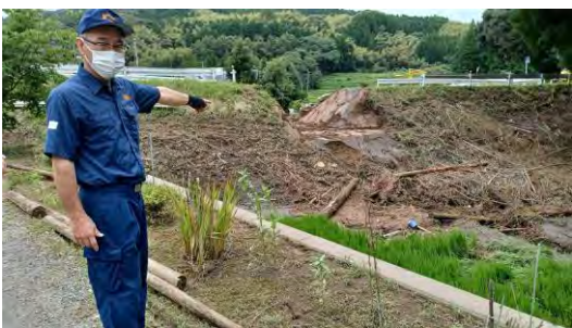
和水町の被災現場を視察する山本県議
