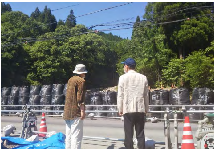
山腹崩落現場を視察する山本のぶひる県議(右)=小国町
