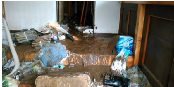
床上まで泥水がたまり、家財が散乱している被災家屋(人吉市。山本伸裕撮影)
