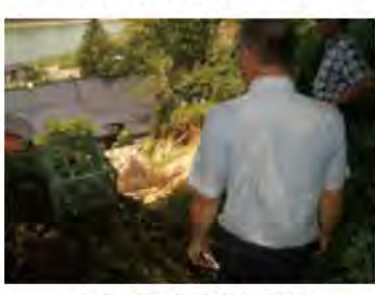
人吉市の土砂崩れ現場
