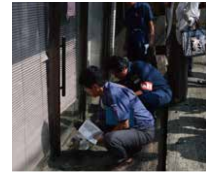
熊本市日吉地区の液状化被害を調査する山本県議ら=8月
